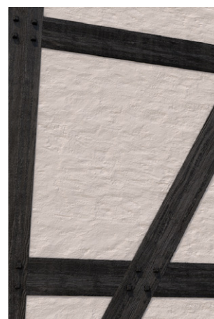
3 Grondlaag van Primer Hydro SF aanbrengen en vervolgens coaten met Color CL Historic
