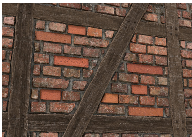
2 Beschadigde stenen vervangen of met RM pro repareren
