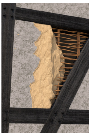
1 Oude opvulmortel verwijderen
